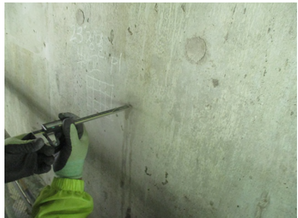
탄산화깊이 측정 현황
